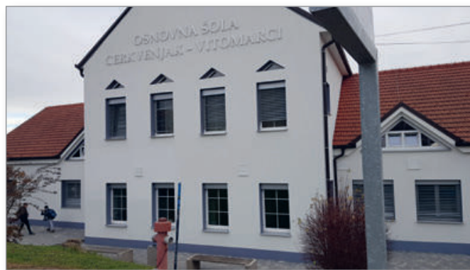
Novo pročelje objekta OŠ Cerkevjak
