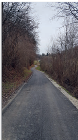
Obnovljena cesta Andrenci–Živko
